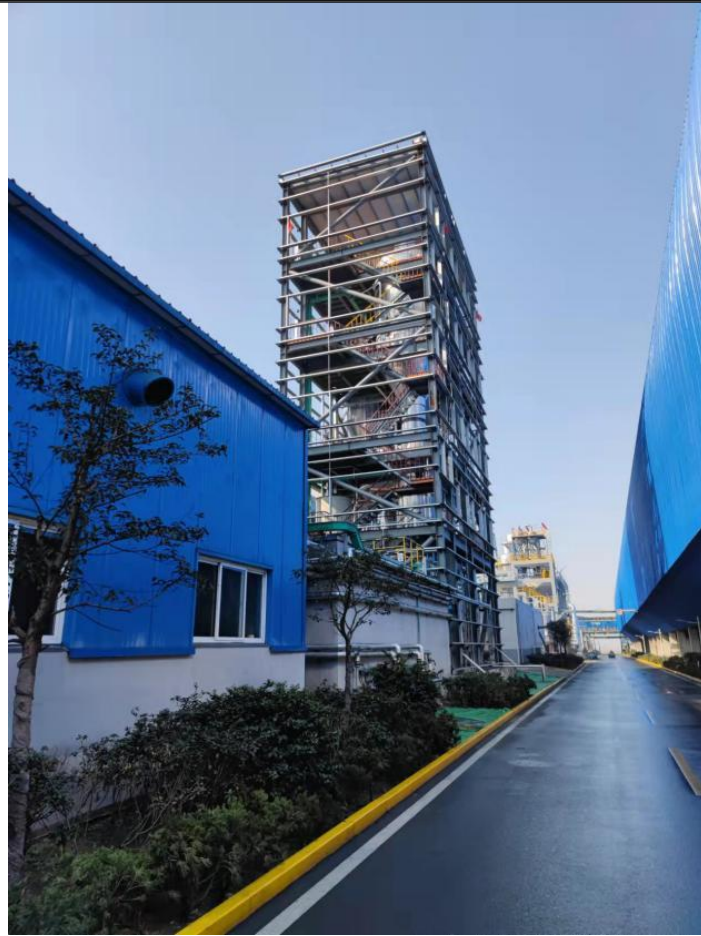
MVR多效蒸发装置
